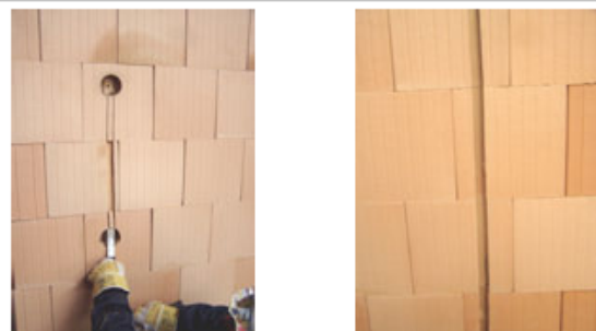
4. Vorgesägte Schlitze mit dem Hammer und Meißel freischlagen
